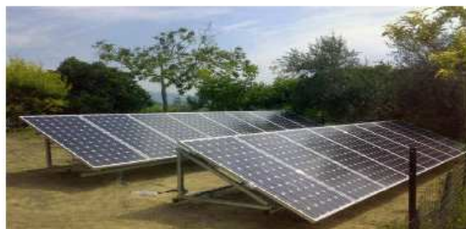
Esempi di installazione non integrata
