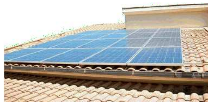
Esempi di installazione su tetto parzialmente integrato
