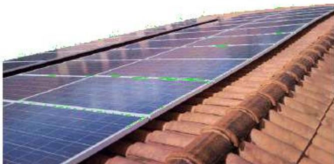
Esempi di installazione su tetto parzialmente integrato
