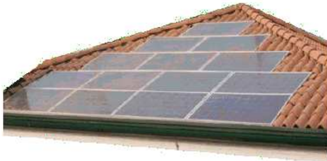
Esempi di installazione su tetto integrato
