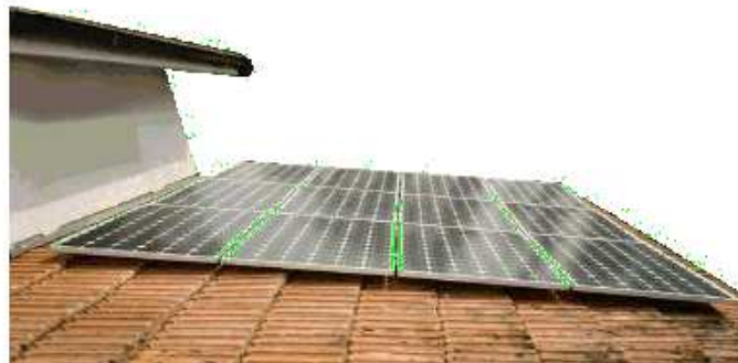
Esempi di installazione su tetto parzialmente integrato
