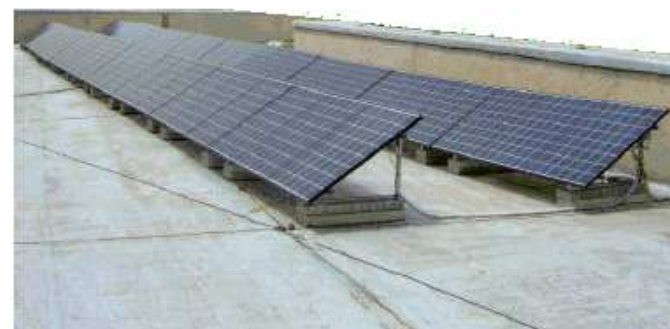
Esempi di installazione su tetto parzialmente integrato
